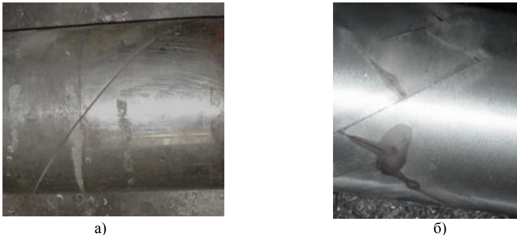
Рисунок 4 – Трещины в средней части гребного вала: а) под углом к оси, б) пересекающиеся
