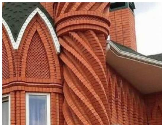
Рисунок 6 – Елементи рельєфної кладки на фасаді будівлі
