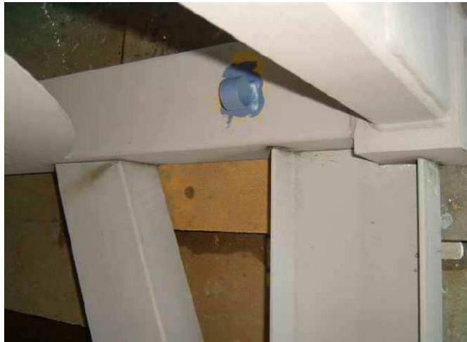
Рисунок 2 – Підготовка рами до зварювальних робіт
