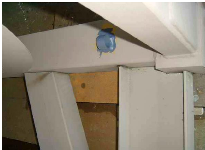
Рисунок 2 – Підготовка рами до зварювальних робіт
