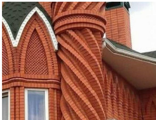
Рисунок 6 – Елементи рельєфної кладки на фасаді будівлі
